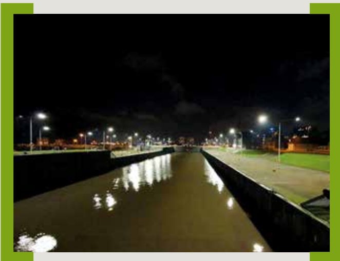
New lighting at Fischereihafen lock
